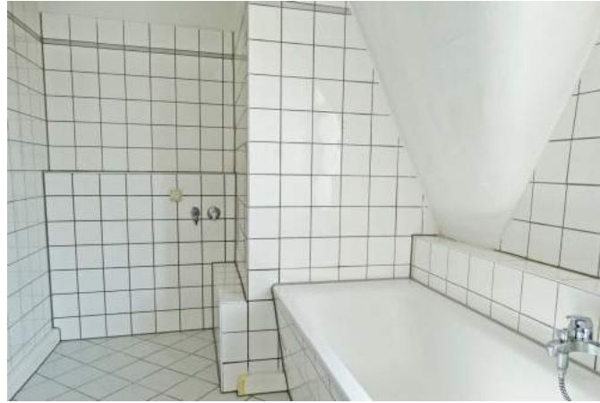
Waschmaschinenanschluss
